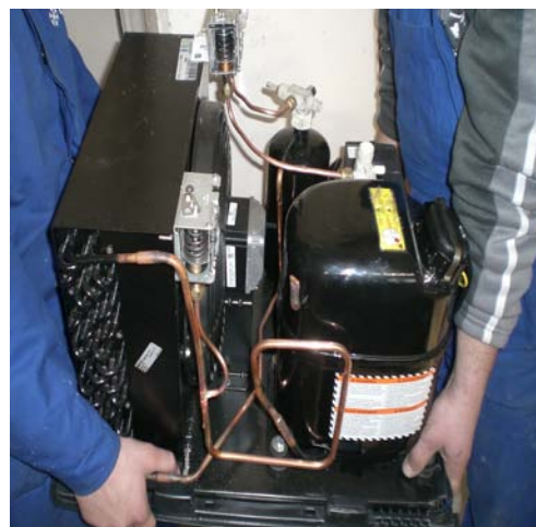
Grup compresor- condensator aferent spatiu refrigerare 0-4C
